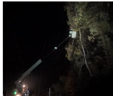
高所作業車による伐採作業
