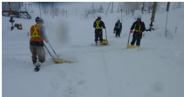
踏切の除雪作業
