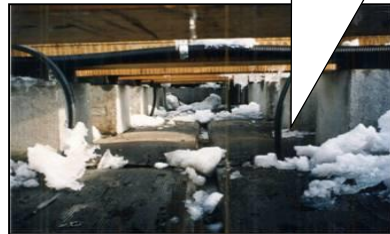
ピット内での融雪状況
