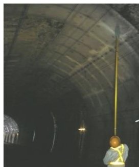
トンネル内のつらら落とし作業
