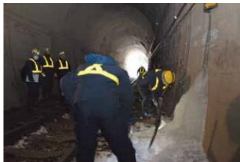
トンネル内の結氷除去作業
