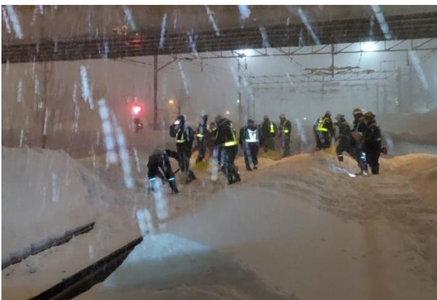
夜間の除雪作業
