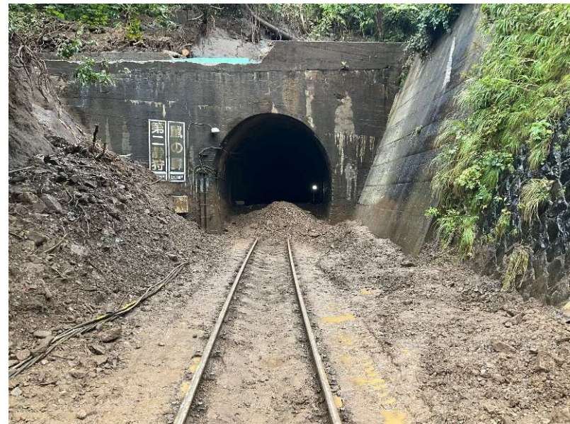
復旧作業中(9/2 15:00現在)
