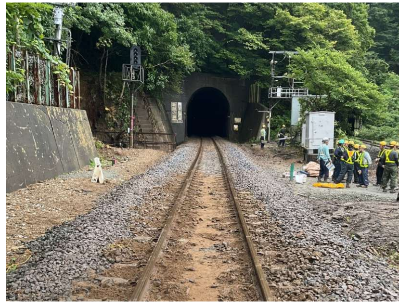
復旧完了(9/2完了)
