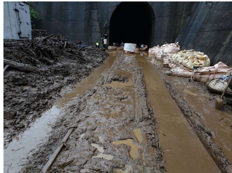
復旧作業中(9/3 15:00現在)
