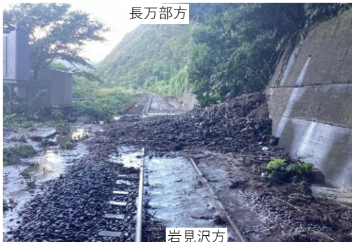
【被災箇所②】土砂流入 静狩～小幌（下り線） 12k173m～181m
