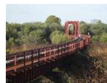
日高線鷗川橋梁
