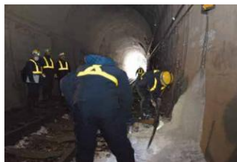
トンネル内の結氷除去作業
