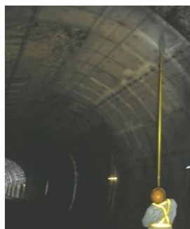
トンネル内のつらら落とし作業
