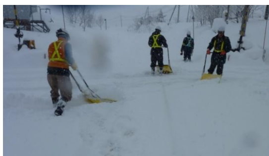
踏切の除雪作業
