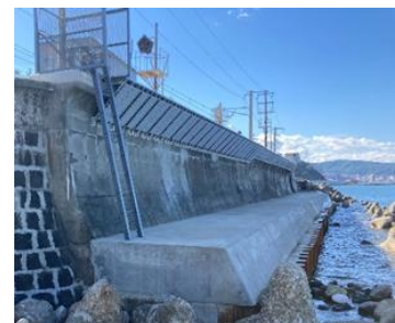
波返し工の設置状況(2025 年 9 月)
