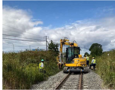
【被災箇所②】道床流出 豊頃～新吉野 223k900m～980m
