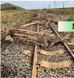
【被災箇所②】 流木集中箇所 264k900m～265k113m
