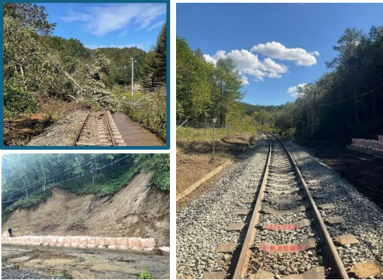
【被災箇所④】道床流出・土砂流入 常豊（信）～上厚内（信） 242k300m～440m
