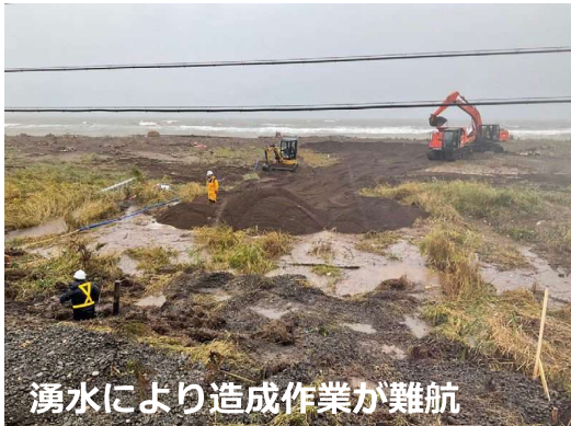
【被災箇所④・⑤共通】 重機搬入経路・ヤード造成
