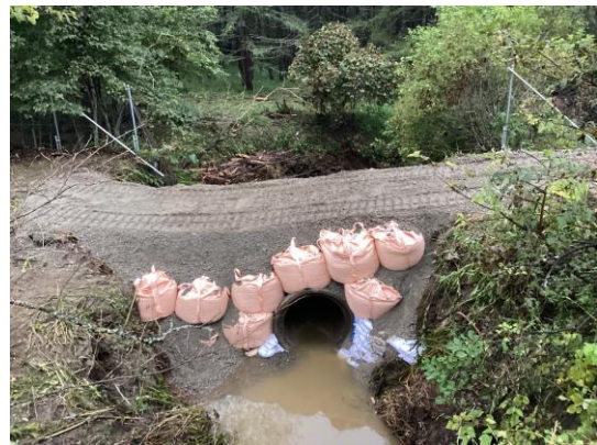
被災箇所までの工事用通路造成中 (9月25日午後時点)
