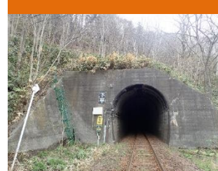
下平トンネル
