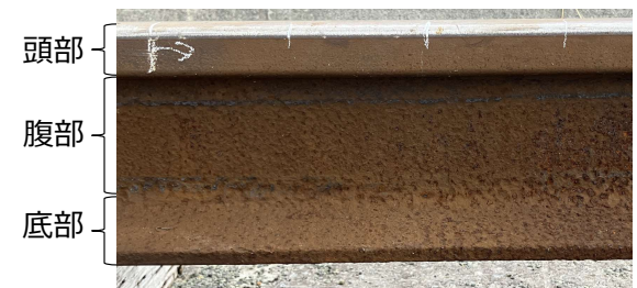
実際に敷設されていたレールの表面凹凸の状況（特に異常なし）
