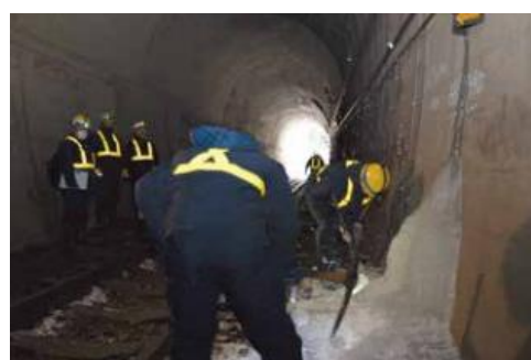
トンネル内の結氷除去作業
