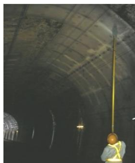
トンネル内のつらら落とし作業
