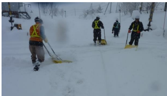
踏切の除雪作業
