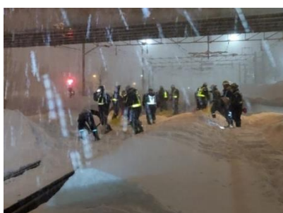
夜間、雪が降る中での人力除雪作業（岩見沢駅）
