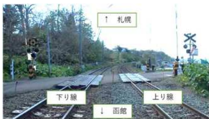
鷺ノ木道路踏切全景（令和元年撮影）
