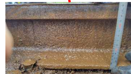
鷺ノ木道路踏切上り線側右レール （経年32年）
