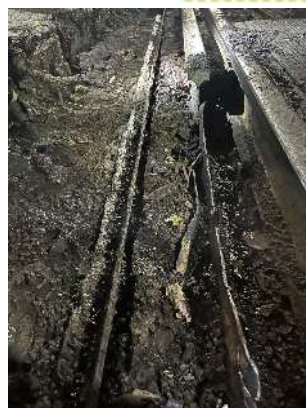
鷺ノ木道路踏切下り線側右レール（著しい腐食あり）
