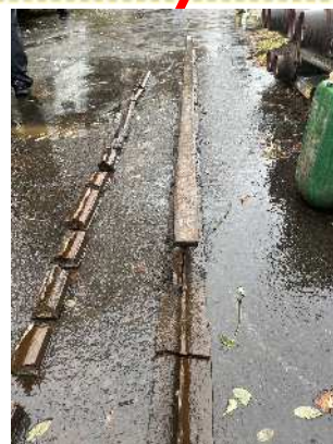
鷺ノ木道路踏切下り線側右レール（著しい腐食あり）
