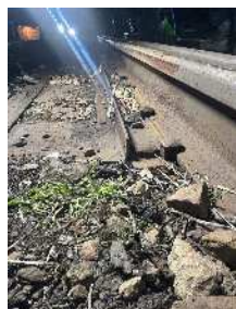
鷺ノ木道路踏切 下り線側左レール （経年14年）
