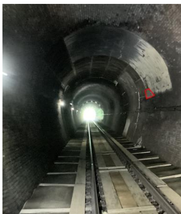
写真1 剥落箇所
