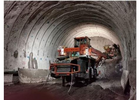
工事中のトンネル (イメージ)
