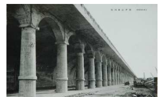
【稚内港北防波堤ドーム】
