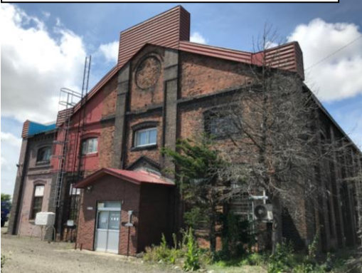
岩見沢ウォーク／岩見沢レールセンター
