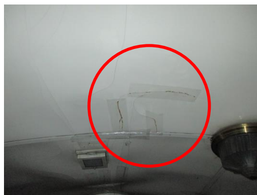
天井化粧板のひび割れ
