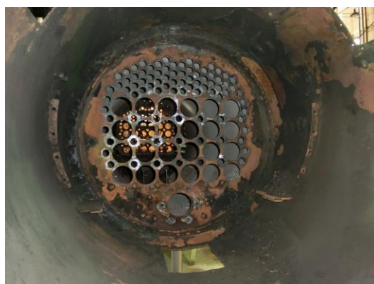
ボイラー内部 (過去修繕時)
