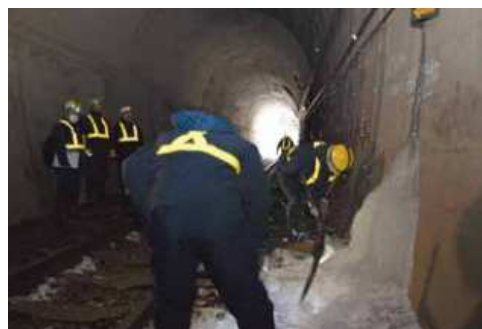
トンネル内の結氷除去作業
