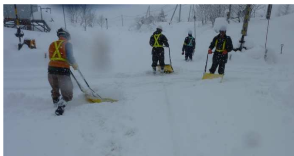
踏切の除雪作業
