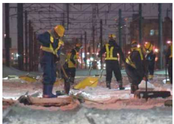
夜間のポイント除雪作業
