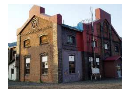
(岩見沢レールセンター)
