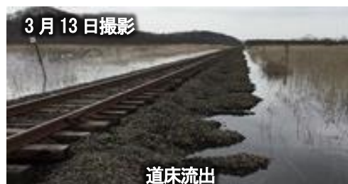
花咲線 厚岸～糸魚沢間の線路冠水箇所の被災状況
