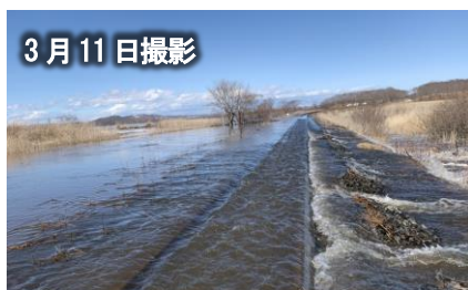
釧網線 茅沼～塘路間の線路冠水箇所の被災状況
