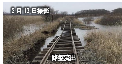
釧網線 茅沼～塘路間の線路冠水箇所の被災状況
