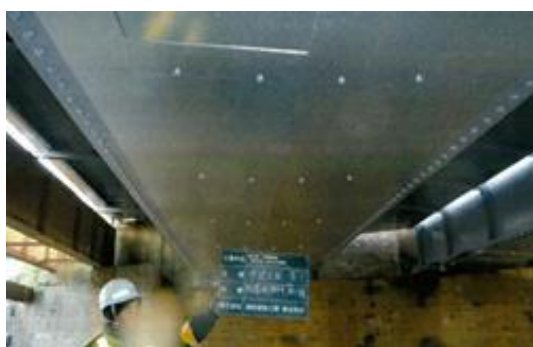
写真3 防塵板設置状況(発生前)
