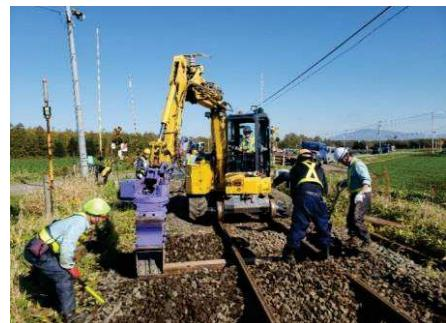
中長期的に鉄道設備を維持するための取組として、10月21日～11月1日、網走～知床斜里駅間で、一部列車を運休して線路集中メンテナンスを行いました。計画どおり約4,000本の木製マクラギを交換し、線路状態を改善しました。
