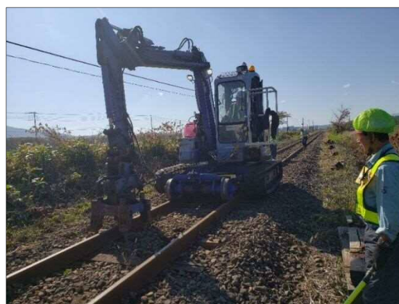
写真2. 重機による道床つき固め作業
