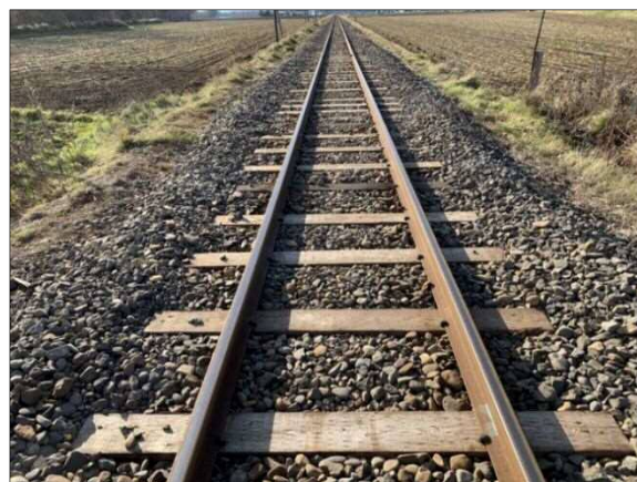
写真4. 施工後の線路状態
