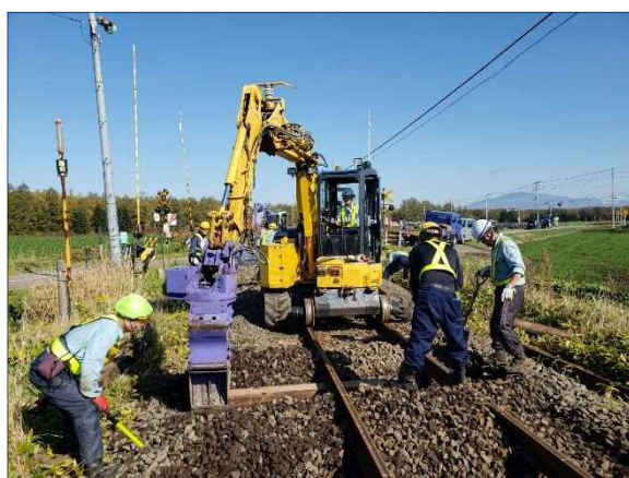
写真1. 重機によるマクラギ交換作業
