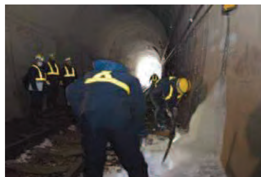
トンネル内の結氷除去作業
