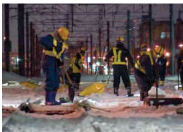
夜間のポイント除雪作業
