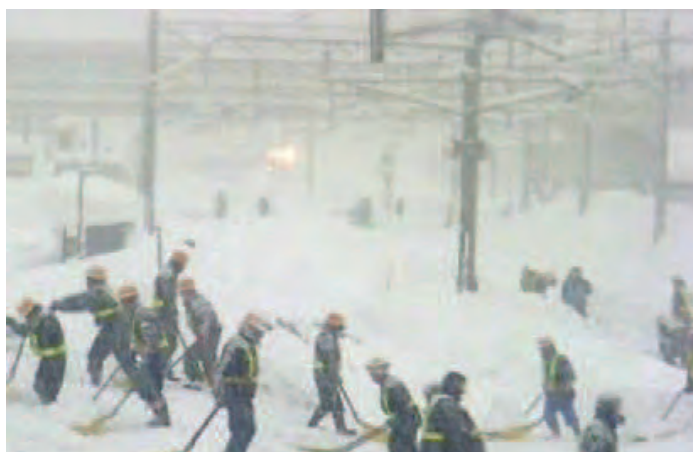
駅構内の除雪作業
