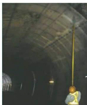
トンネル内のつらら落とし作業
