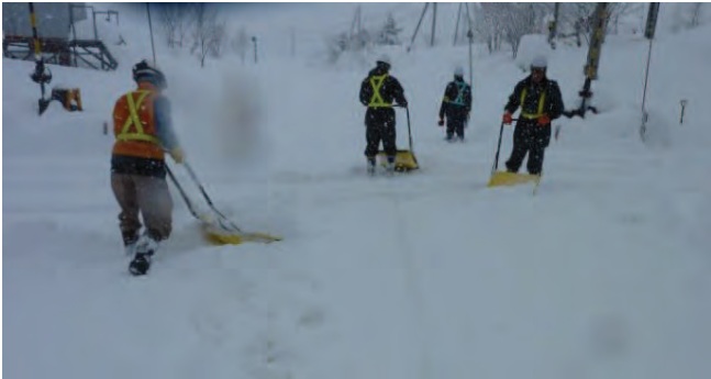
踏切の除雪作業
