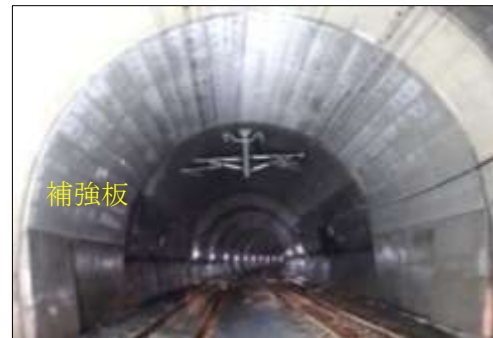
覆工コンクリートの補強状況
