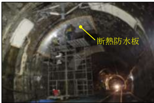
不燃化した断熱防水板設置の様子
