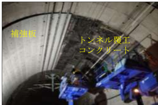
覆工コンクリートの補強の様子 トンネル覆工が特に傷んでいる箇所にセメント板を設置
