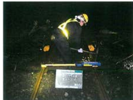
クギ打ち作業（軌間計測機器で確認）
