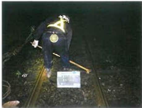
クギ抜き作業
