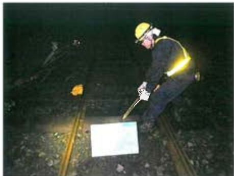
マクラギ挿入作業
