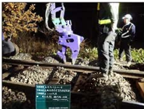
マクラギ挿入作業
