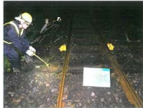
マクラギ撤去作業
