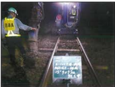
マクラギ撤去作業
