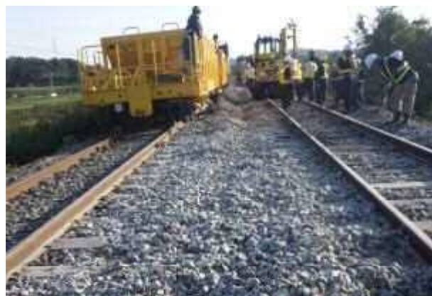
室蘭線 追分～三川間 線路復旧作業
