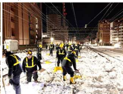
計画運休による集中的な除雪作業
