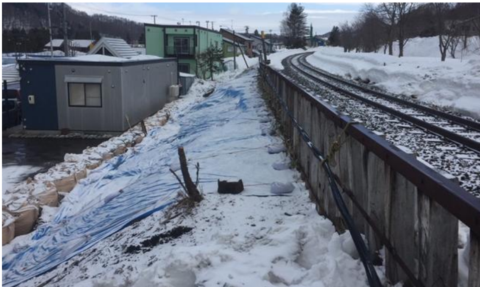
【現地の状況（全景）】
