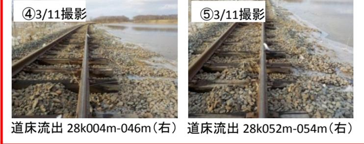
道床流出 28k004m-046m(右) 道床流出 28k052m-054m(右)
