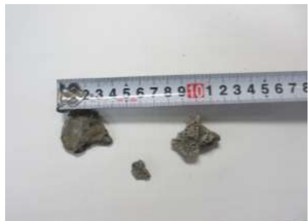
写真2 落下したコンクリート片
