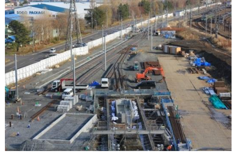
▲実習線工事状況(平成28年11月撮影)
