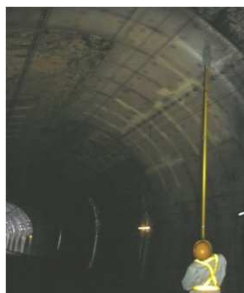
トンネル内のつらら落とし作業
