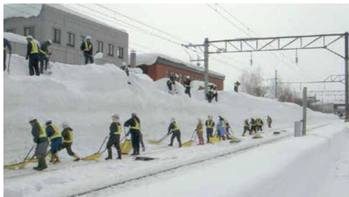
駅構内の除雪作業
