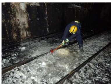
トンネル結氷除去作業
