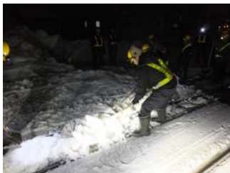
夜間の除雪作業
