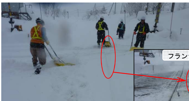
踏切の除雪作業
