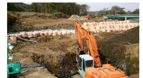
橋脚基礎掘削中
