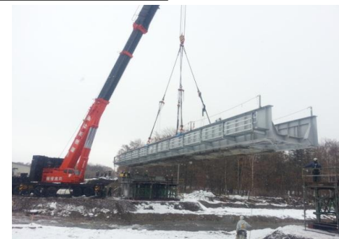
橋桁架設中(11月8日)
