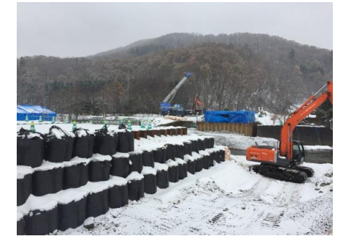
復旧作業中（11月8日時点）
