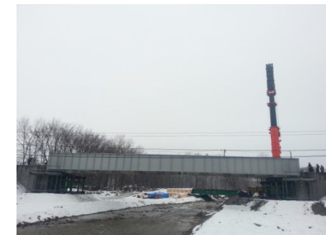
橋桁架設完了(11月8日)
