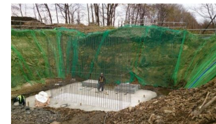
第2橋台鉄筋施工中
