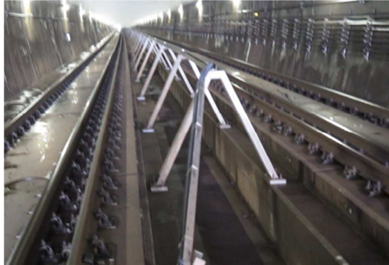
限界支障報知装置(青函トンネル内)
