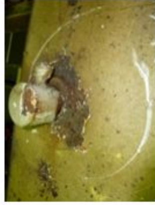
屋根構体腐食
