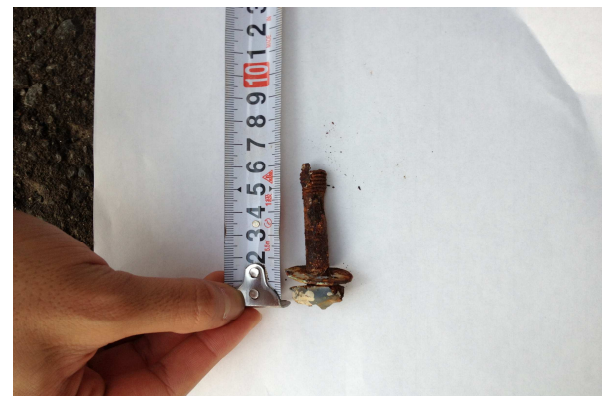
【脱落したボルト】
