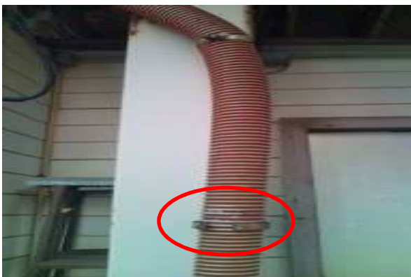
【ボルトが外れた締結用バンド】
