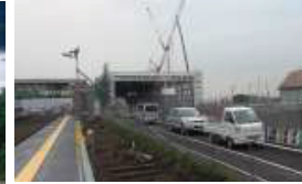
新幹線工事風景(渡島大野駅)
