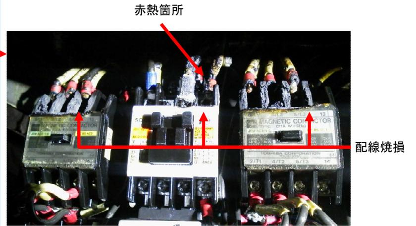
接触器 (左から、CFK1、EFK1、CFK2)
