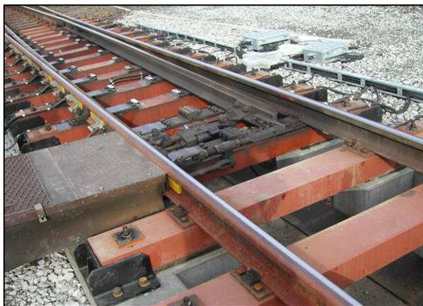
ポイント下部にコンクリートで箱型に空間(ピット)を設け、降雪などを落とし込む構造にするとともに、ピットの底部に敷いたパネルヒーターで融雪する設備です。
