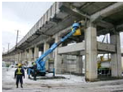
緊急点検の様子
