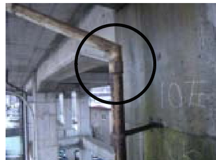
鋼管継ぎ目部
