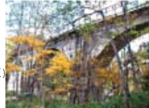
旧国鉄土幌線コンクリートアーチ橋梁群 (上士幌町)
