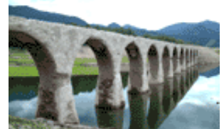
旧国鉄土幌線コンクリートアーチ橋梁群
