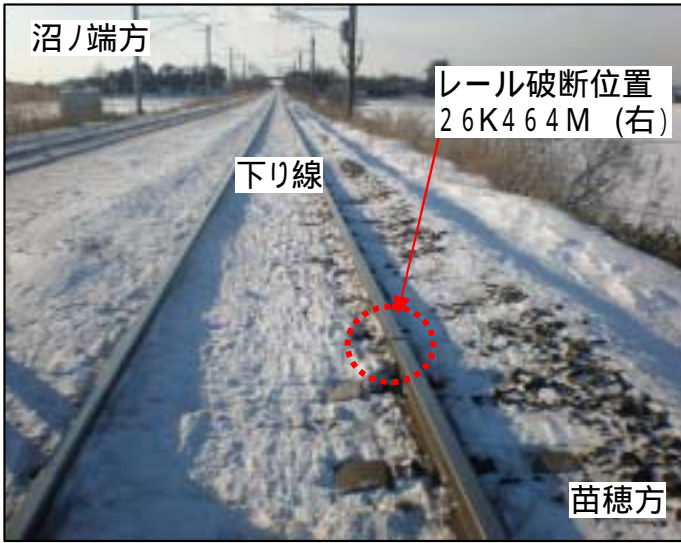
【レール破断状況】
