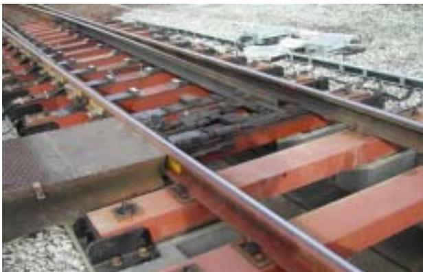
ポイント下部にコンクリートで箱型に空間(ピット)を設け、降雪などを落とし込む構造にするとともに、ピットの底部に敷いたパネルヒーターで融雪する設備です。
