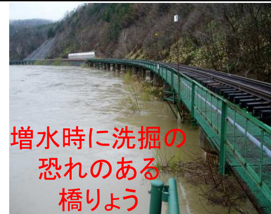
(例: 宗谷線 糠南・雄信内間 問平陸橋)
