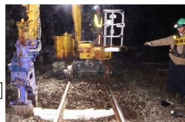
PC マクラギ化工事 (根室線)
