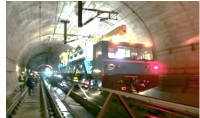
電車線の張替
