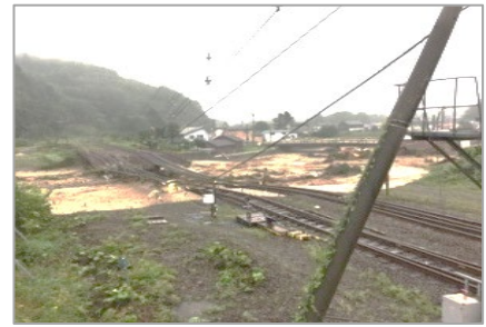
根室線新得駅構内 橋りょう流失（平成 28 年 8 月）
