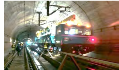
電車線の張替
