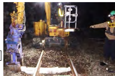
PC マクラギ化工事 (根室線)
