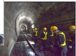
石勝線列車脱線火災事故の現地確認
