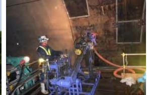
トンネル変状対策
