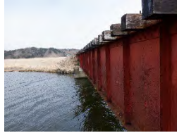
根室線厚岸～茶内間 第6尾闕川橋りょう (大正8年完成)
