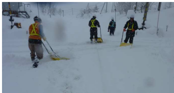
踏切の除雪作業
