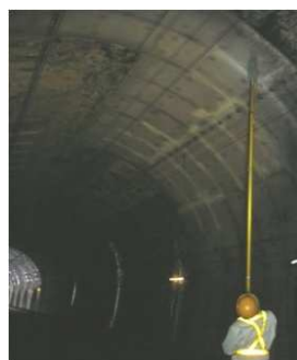
トンネル内のつらら落とし作業
