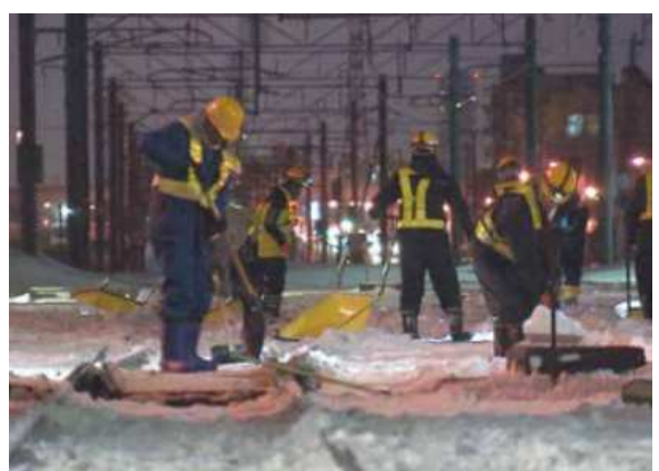
夜間のポイント除雪作業
