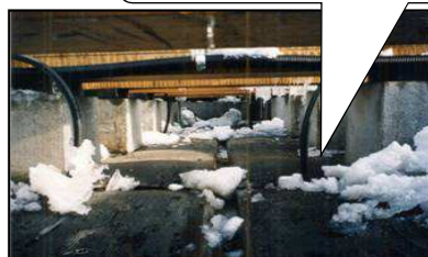
ピット内での融雪状況
