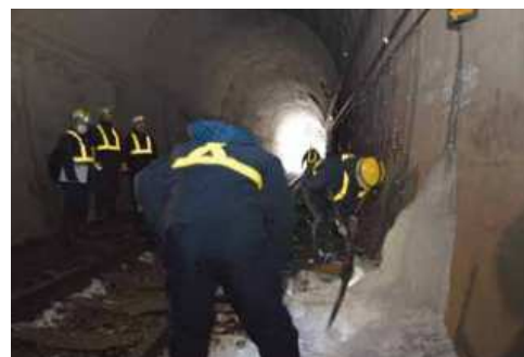
トンネル内の結氷除去作業
