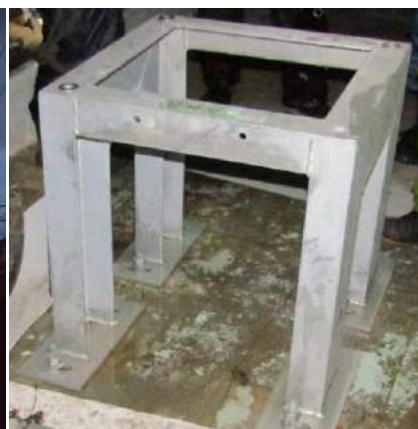
【新設した基礎】
