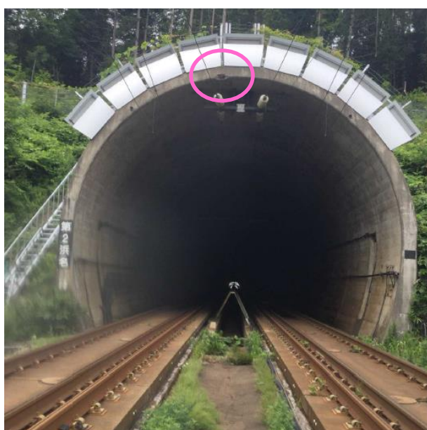
写真1 剥落箇所
