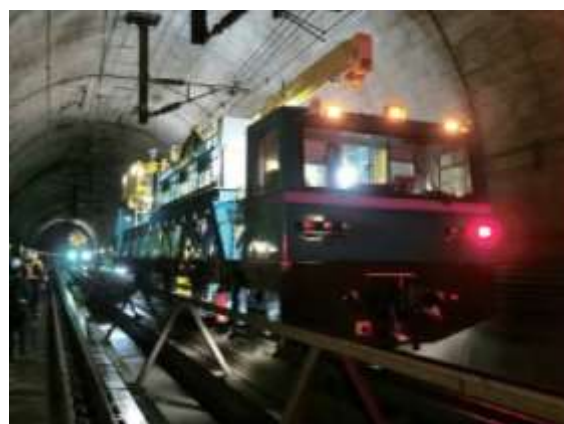
【青函トンネル内の架線交換工事】
